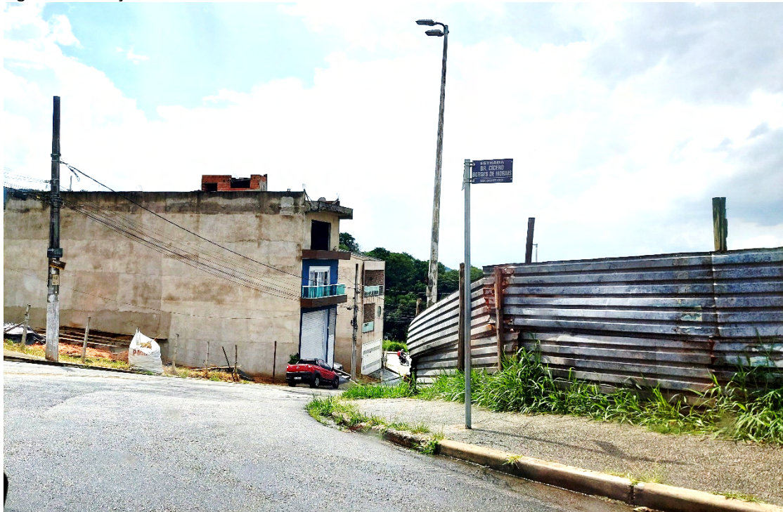
Figura 1-14 Calçada no bairro dos Altos
