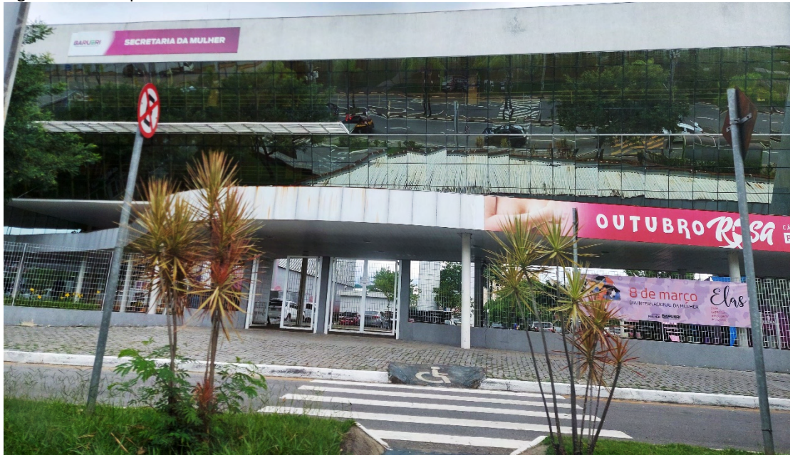
Figura 1-22 Rampa de acessibilidade existente no bairro Boa Vista
