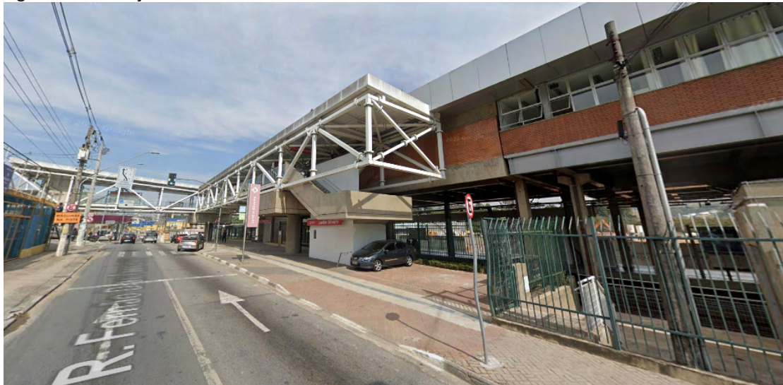
Figura 1-102 Estação Jardim Silveira
