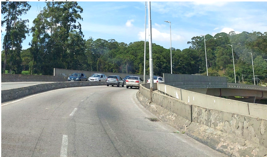
Figura 1-19 Espaço para pedestres no Viaduto dos Trabalhadores
