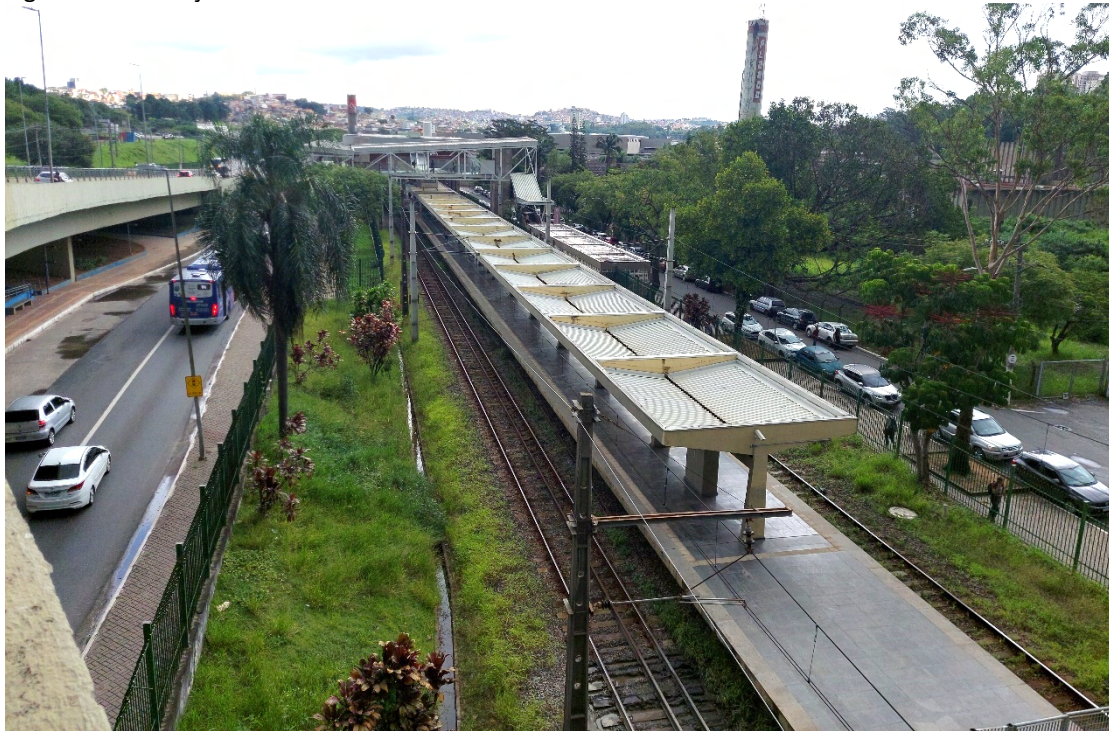
Figura 1-104 Estação Jardim Belval
