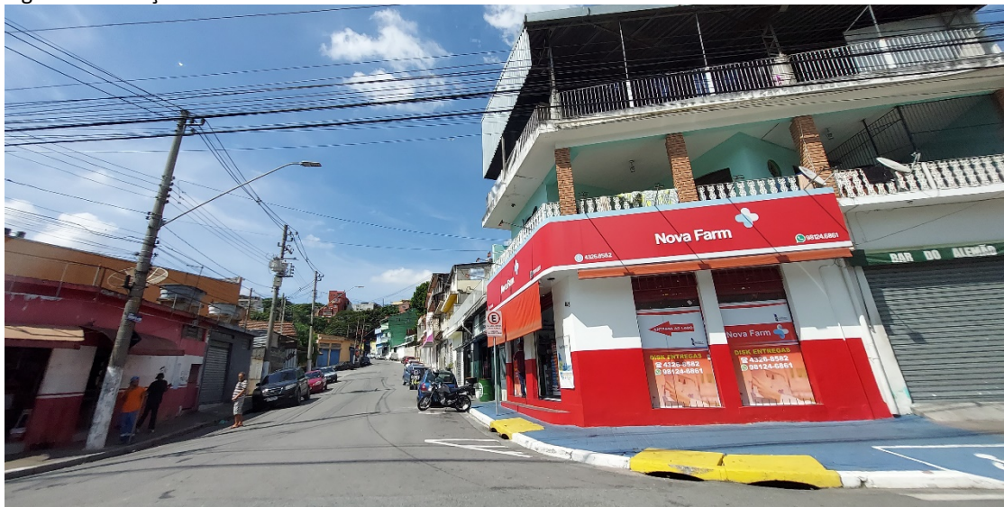
Figura 1-15 Calçada no bairro Jardim Belval
