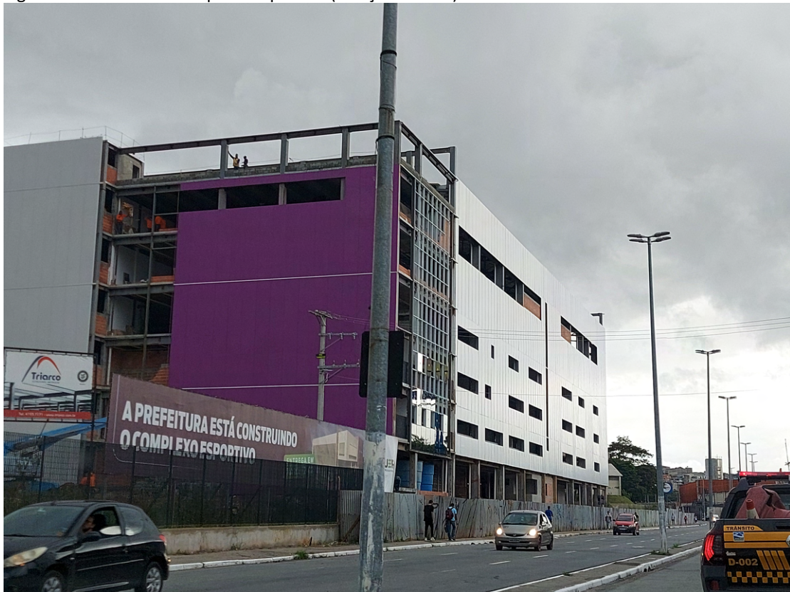
Figura 1-125 Obra do Complexo Esportivo (Março de 2022)
