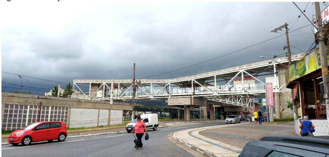
Figura 1-101 Estação Jardim Silveira
