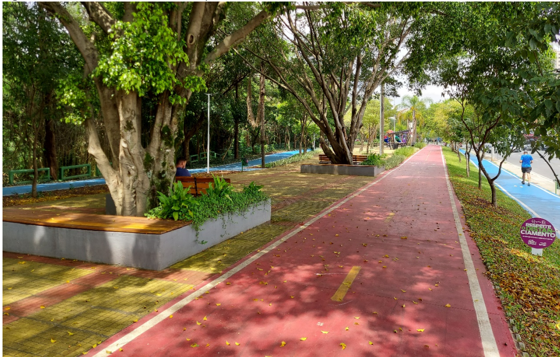
Figura 1-29 Ciclovia existente no Parque Linear, bairro Boa Vista
