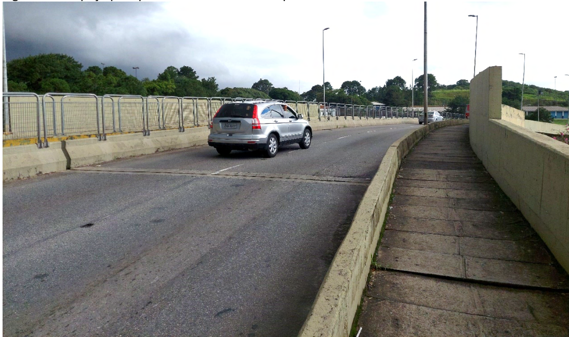
Figura 1-18 Espaço para pedestres no Viaduto Joaquim Antunes da Silva
