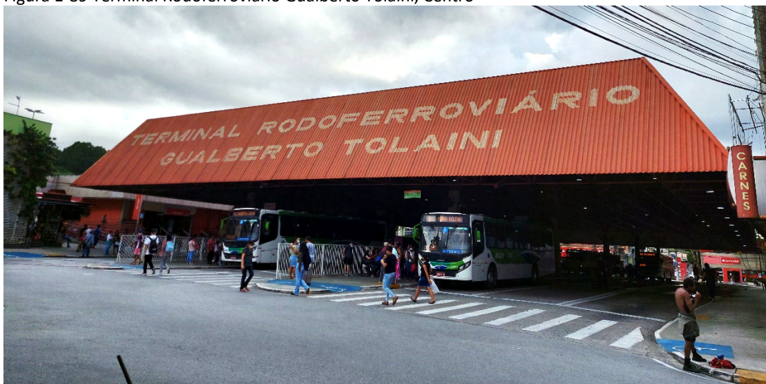
Figura 1-89 Terminal Rodoferroviário Gualberto Tolaini, Centro
