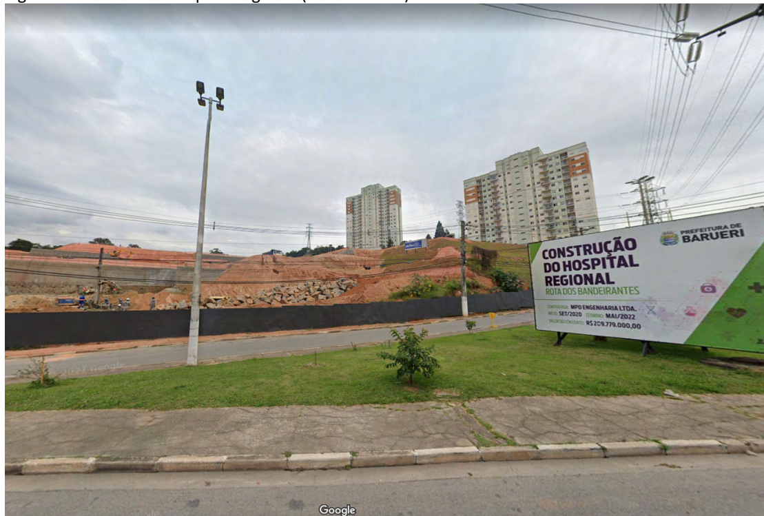
Figura 1-127 Obra do Hospital Regional (abril de 2021)
