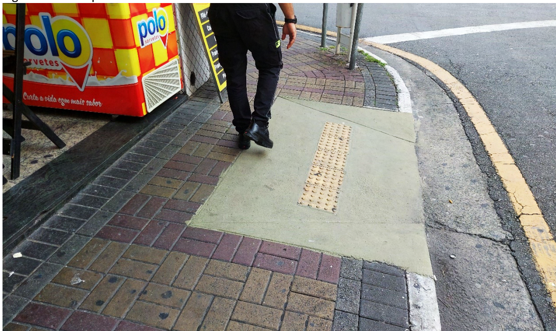
Figura 1-20 Rampa de acessibilidade no bairro Centro
