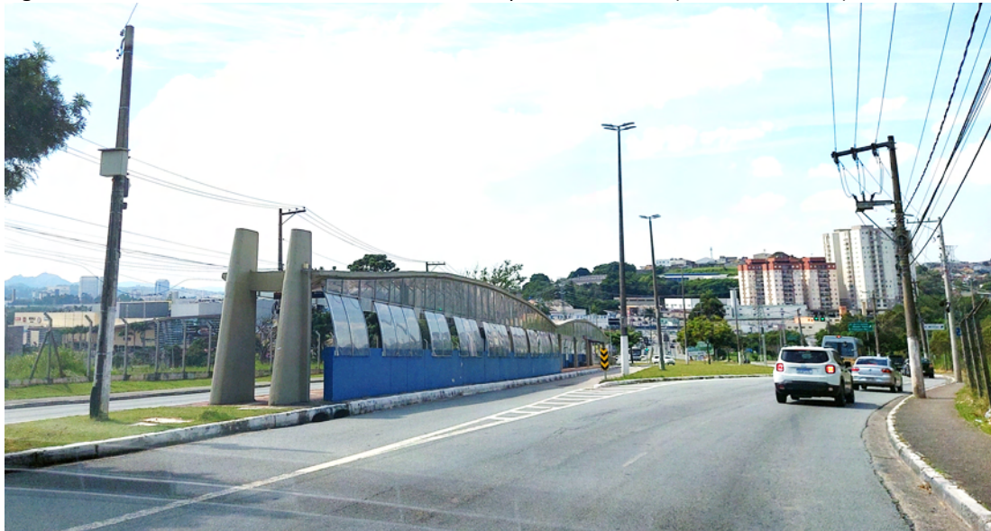
Figura 1-84 Ponto de ônibus central do Corredor Itapevi a São Paulo (Via Mal. Rondon)
