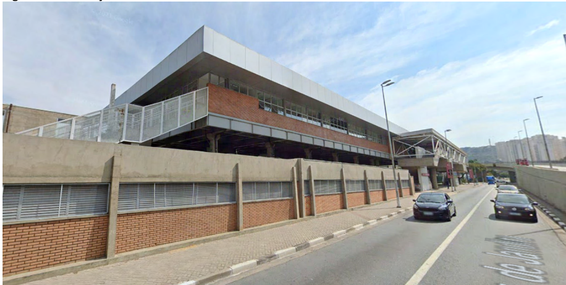
Figura 1-105 Estação Jardim Belval
