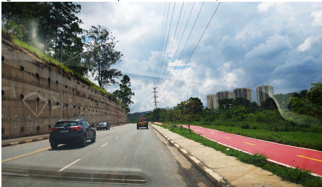
Figura 1-30 Ciclovia existente no Parque Linear – Rua Antonio Furlan, bairro Cruz Preta
