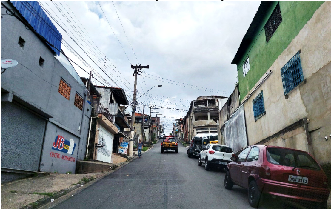
Figura 1-12 Calçadas em vias excessivamente íngremes no bairro Engenho Novo
