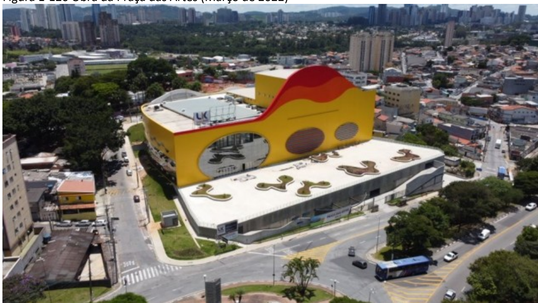
Figura 1-126 Obra da Praça das Artes (Março de 2022)
