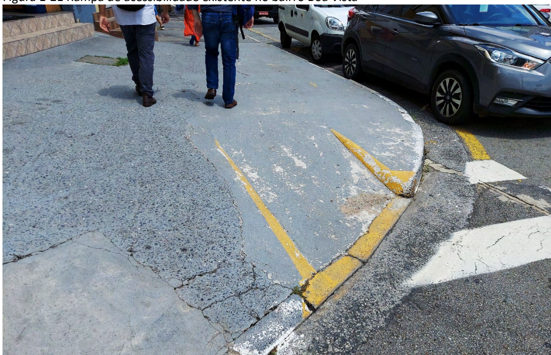
Figura 1-21 Rampa de acessibilidade existente no bairro Boa Vista
