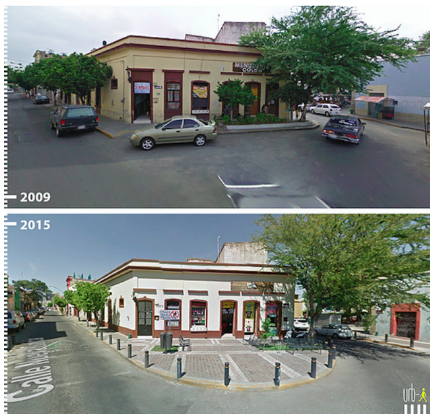
Figura 2-3 Exemplo de intervenção em cruzamento para melhoria do conforto e segurança dos pedestres
