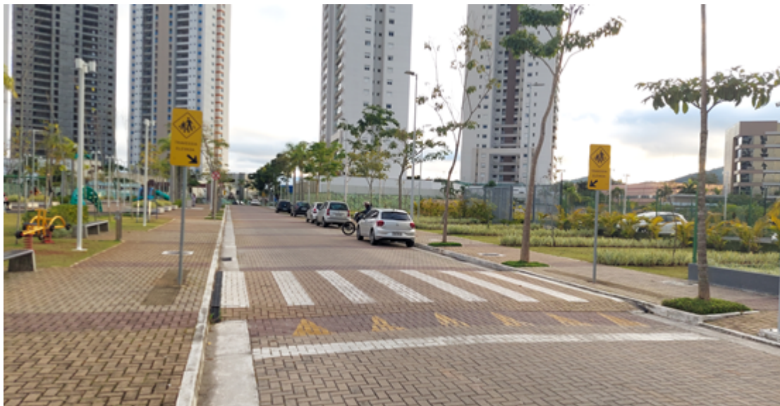
Figura 1-40 Av. Dr. Benedicto Laporte Vieira da Mattos, Mogi das Cruzes, pista com piso intertravado e travessia elevada.
