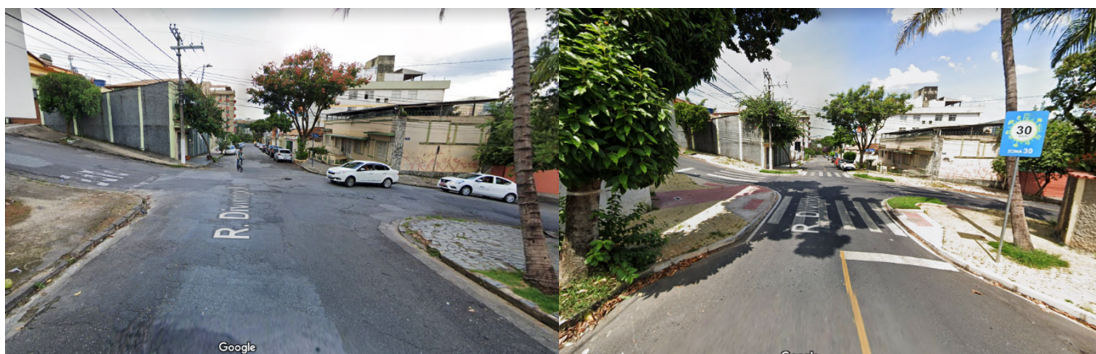
Figura 1-38 Alargamento de calçadas em zona 30 - Rua Divinópolis, Bairro de Santa Tereza, Belo Horizonte/MG
