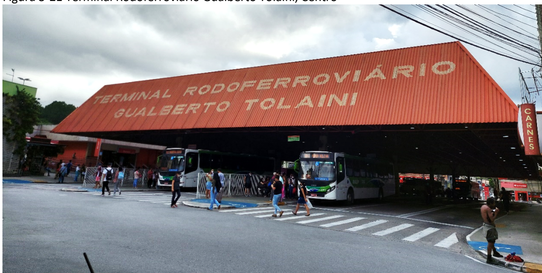
Figura 3-21 Terminal Rodoferroviário Gualberto Tolaini, Centro
