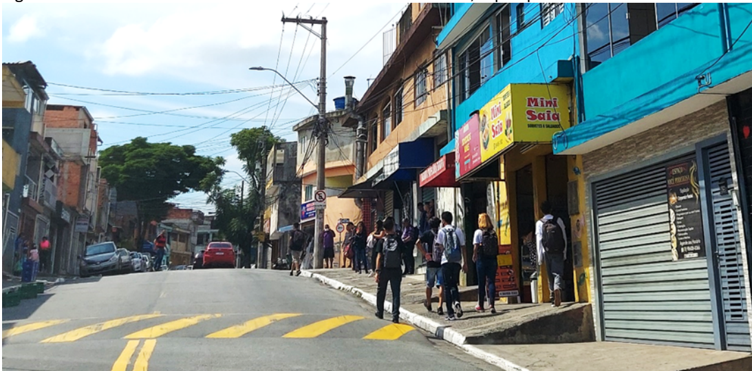
Figura 3-23 Parada de ônibus sem estrutura na R. Duarte Costa, Pq. Imperial
