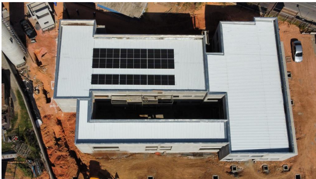
Figura 62: Paineis Fotovoltaicos na UBS Bairro dos Altos
