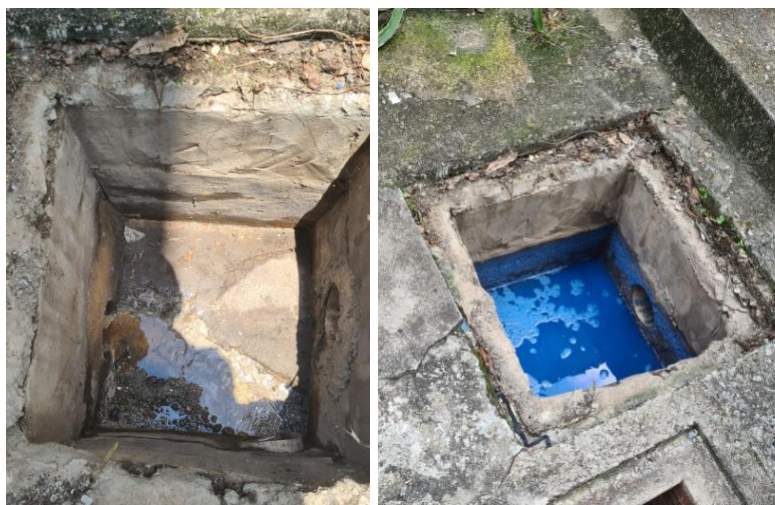
Figura 44: Teste de corante utilizado na fiscalização do lançamento de esgoto sanitário
