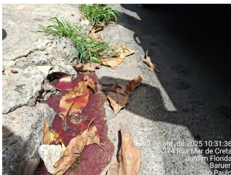
Figura 48: Lançamento irregular na via pública
