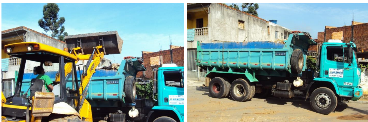
Figura 3 - Coleta de entulhos com as equipes de limpeza urbana.
