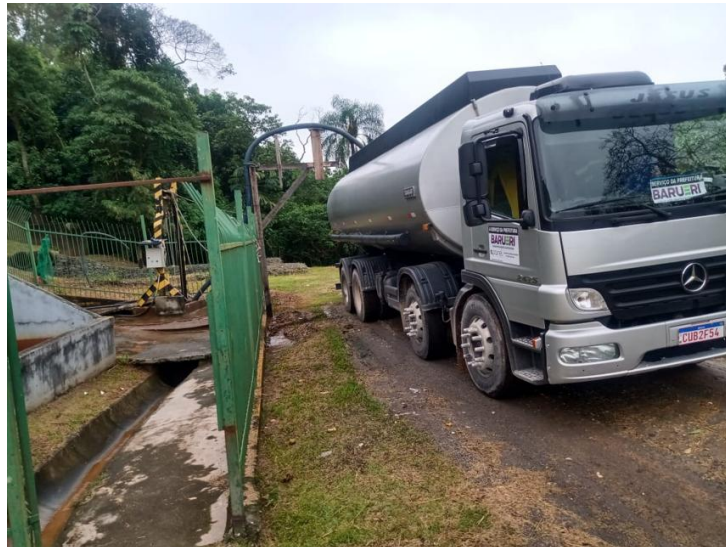
Figura 37 -- Coleta e Remoção de Líquido Percolado no Aterro de Barueri.
