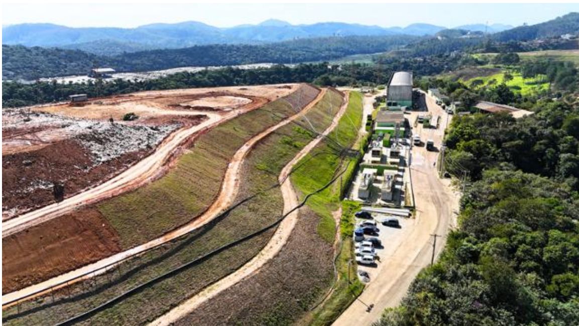
Figura 39- Aterro Sanitário Licenciado da Empresa TECIPAR Engenharia e Meio Ambiente Ltda.
